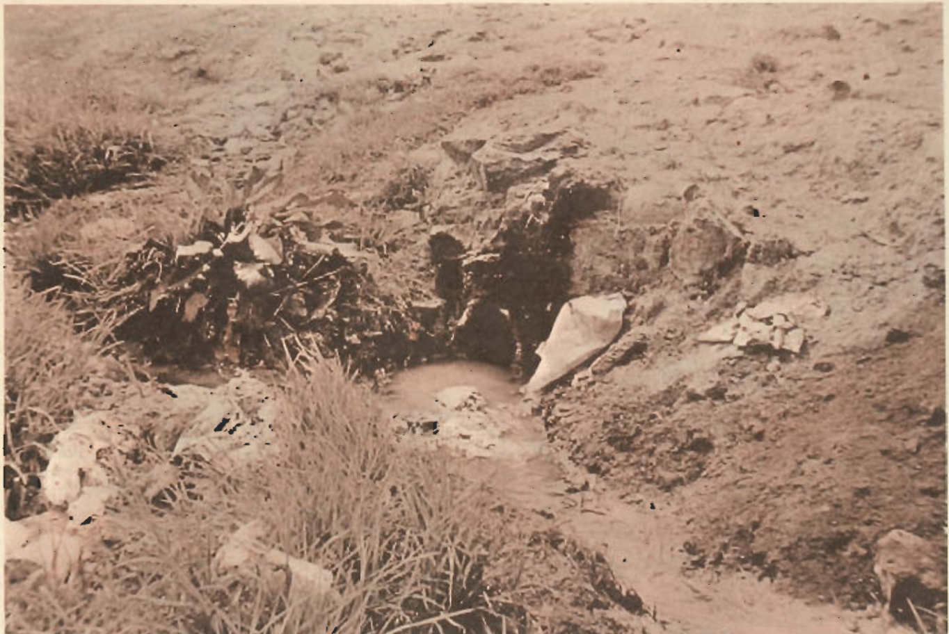
Debido a la gran permeabilidad del terreno, las aguas negras se infiltran y contaminan el acuífero.
